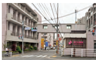
◀右の棟は外来や緩和ケア病棟等がある本館、左の棟は通所リハビリテーション等がある別館
