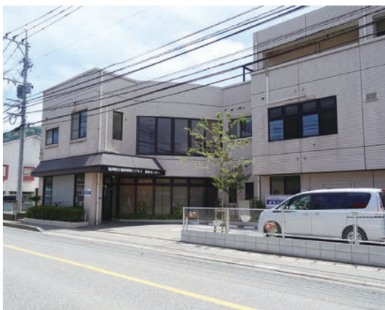
教育センターの外観
